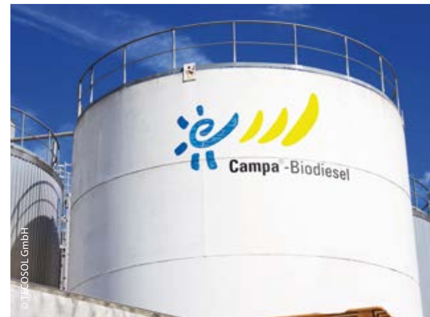
Biodieseltank im Werk Ochsenfurt, Deutschland
