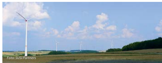
Windkraftanlage „Mörsdorf Süd“ (Deutschland)
